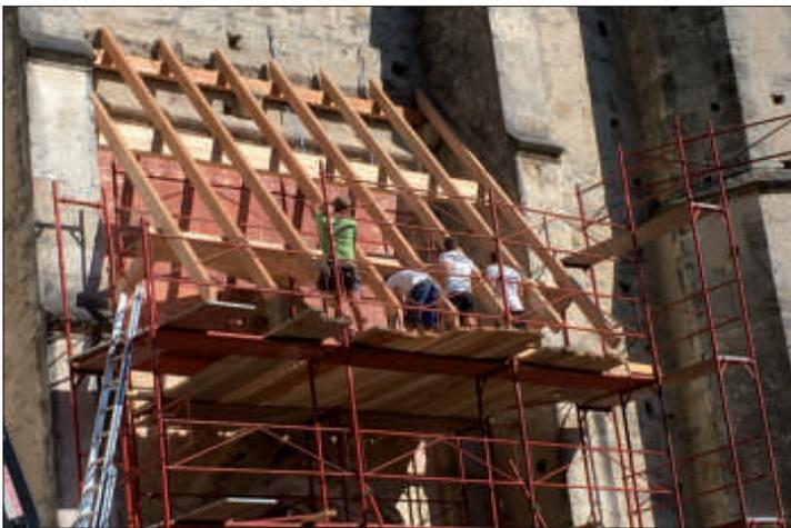
2018 und 2019 wurde eine große Reparatur am nordseitigen Dach durchgeführt, um das Eindringen von Wasser in die Giebelmauern zu verhindern. Das Dach über der Sakristei wurde komplett erneuert, 2020 bekam das Westportal ein neues Vordach. Für das heurige Jahr ist noch die Erneuerung des Geländers auf der talseitigen Stützmauer vorgesehen.
